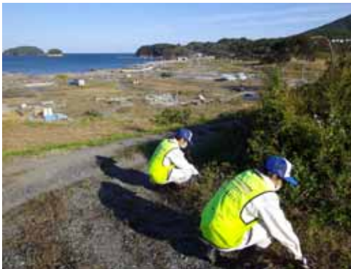
瓦礫撤去・分別作業
