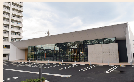
長門・仙崎・油谷支店 2022年10月11日(火)から
