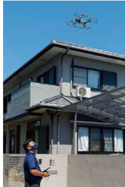
屋根や高い場所の点検にはドローンが大活躍
