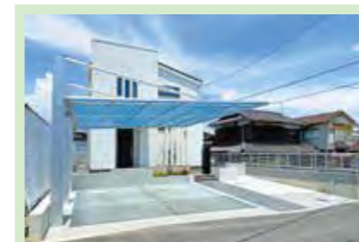
柱が一本のタイプのカーポートを設置
