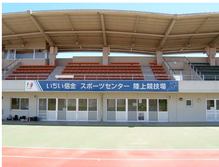
いちい信金スポーツセンター 陸上競技場
