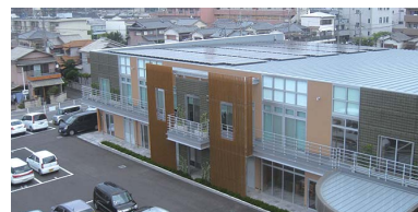
恋の窪未来発電所@ならコープ (年間発電量58,258kwh(平成30年度))
