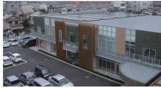
恋の産未来発電所@ならコープ (年間発電量54,256kwh(平成27年度))
