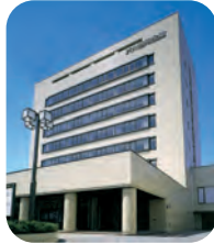
本店新築 (平成元年5月)
