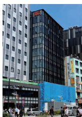
建設工事の様子 (令和5年6月)
