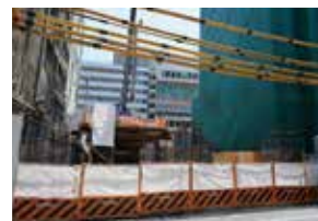
建設工事の様子
