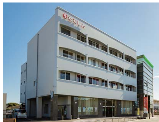
耐震工事後の本店及び新本部ビル
