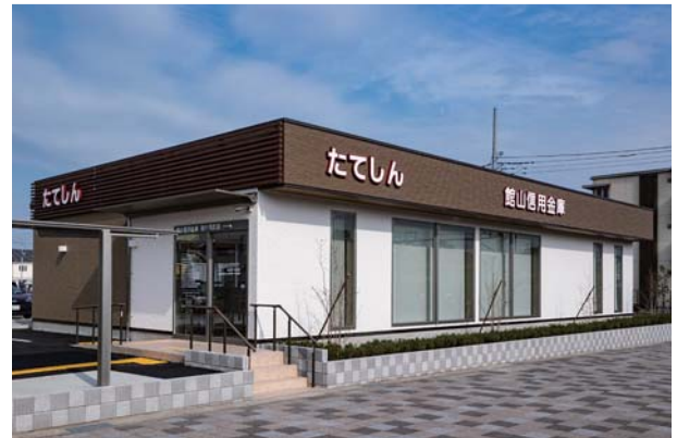
令和3年12月袖ヶ浦支店新築移転
