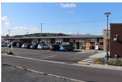
《商業施設の全景》
