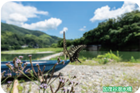
加茂谷潜水橋
