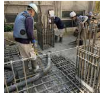
▲耐震補強工事
