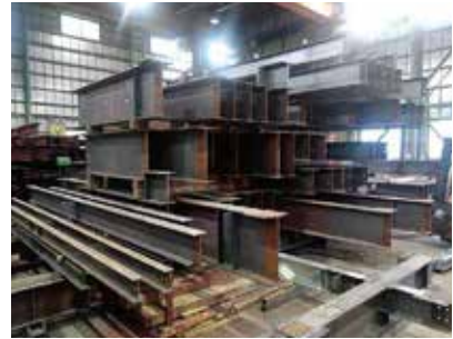
▲加工中の鉄骨の梁
