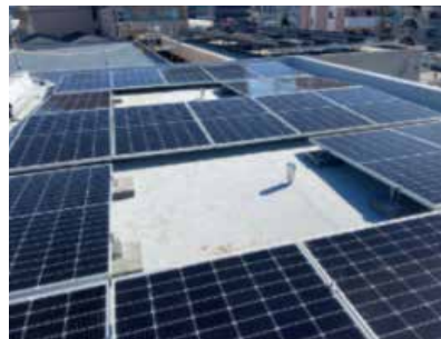
▲施工事例（屋上の有効活用）
