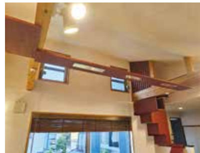
▲施工事例(内観)
