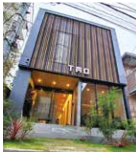
▲施工事例(外観)
