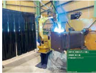
▲溶接ロボット
