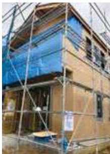
▲白鉄T様邸新築工事
