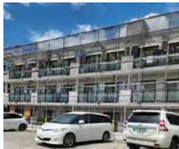
▲賃貸マンション修繕工事
