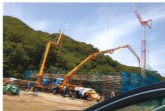
コンクリートポンプ車による工事現場
