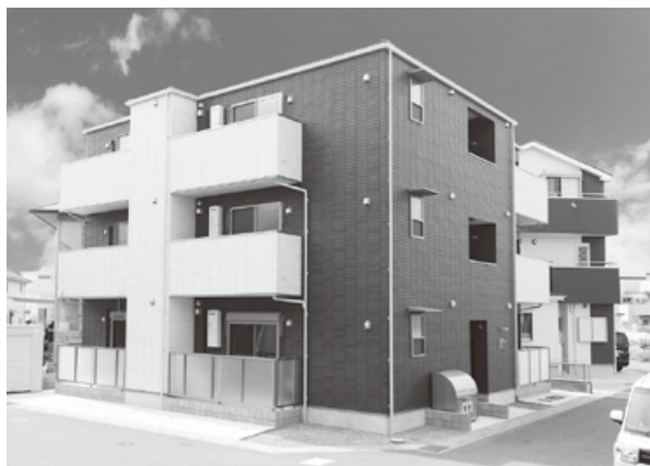
施工実績：共同住宅「アマルフィハ潮」
