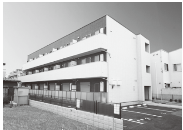
施工実績：共同住宅「AJ南柏WEST I」
