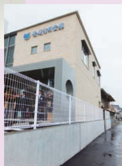
海沿いという立地を考慮し、側道より高い位置に建物の基礎を構築
