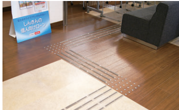
店舗の外からATMや窓口まで誘導する 点字ブロックを設置
