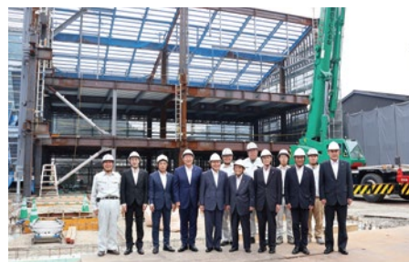
建築が開始された新本部棟
