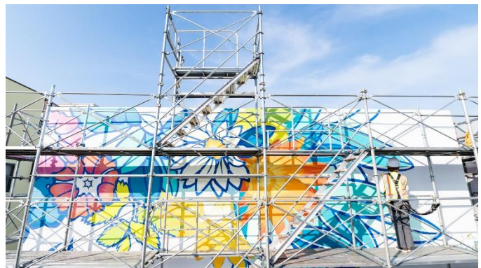
オノルイーゼさんによる須賀支店外壁塗装の様子
