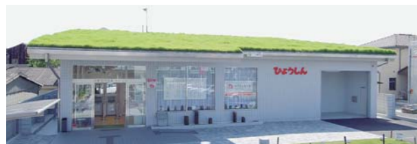
高砂支店 屋上緑化
