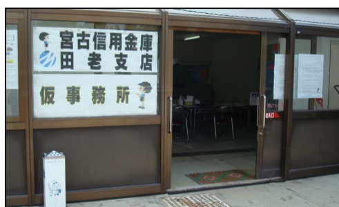
【図表13】田老仮設事務所外観
