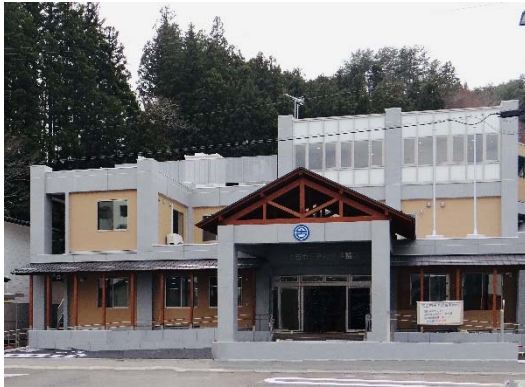
田老総合事務所庁舎
