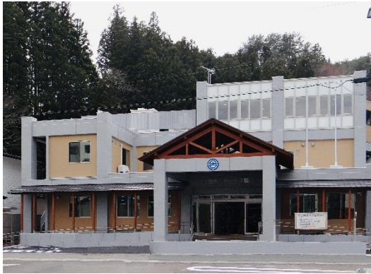
田老総合事務所庁舎
