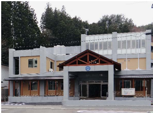
田老総合事務所庁舎
