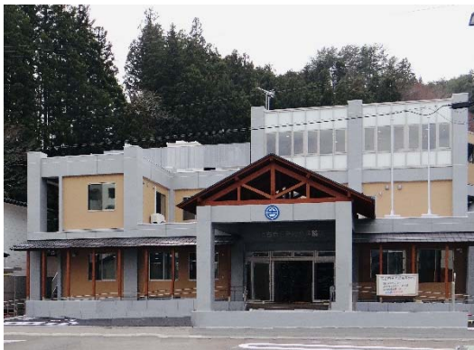
田老総合事務所庁舎
