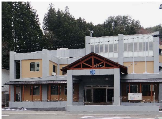
田老総合事務所庁舎
