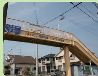
名称：銀座通り歩道橋（一宮市） 愛称：いちい信用金庫 ふれあい歩道橋
