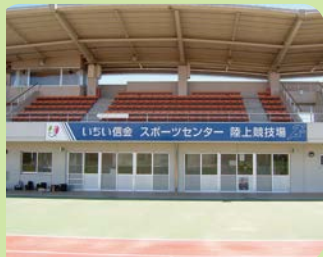
名称:愛知県一宮総合運動場 愛称:いちい信金スポーツセンター
