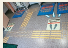
▲点字ブロック
