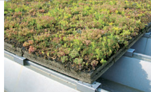
設置した無灌水量屋上緑化基盤材。発泡セラミックスに「セダム」を植栽している。
