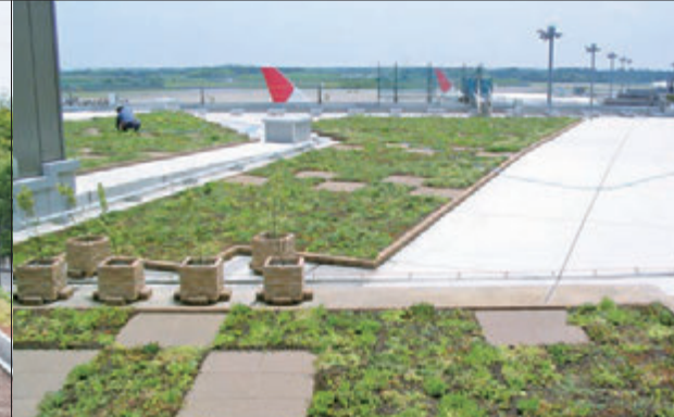
屋上での温度測定の様子。緑化基盤材を設置した部分では、明らかな温度低下が見られた。
