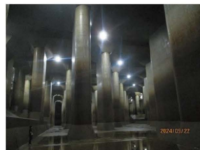
首都圏外郭放水（防災地下神殿）の様子
