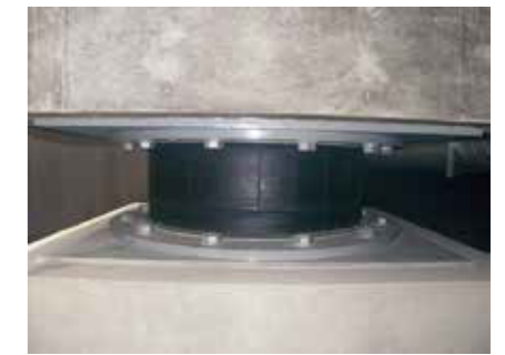
免震装置。国が定める「極めてまれに発生する地震動」を想定して設計されています
