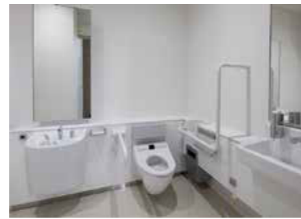
車いす用トイレ。トイレや洗面所には節水型、自動水栓の設備を多く採用しました
