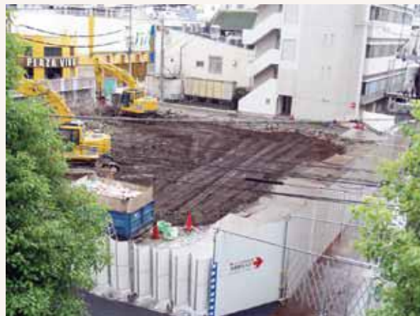
▲解体作業がほぼ終わり、いよいよ新築工事へ（H26.9.25）
