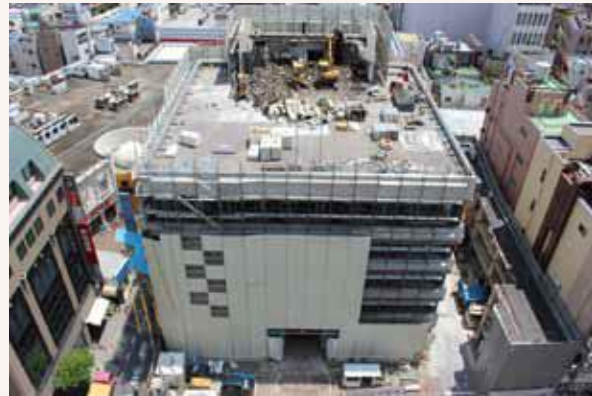
▲重機をクレーンで屋上へ。屋上機械室の取り壊し（H26.7.1）
