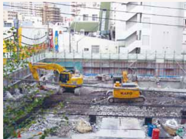
▲壁や柱部分の取り壊しは最後の段階です（H26.9.16）
