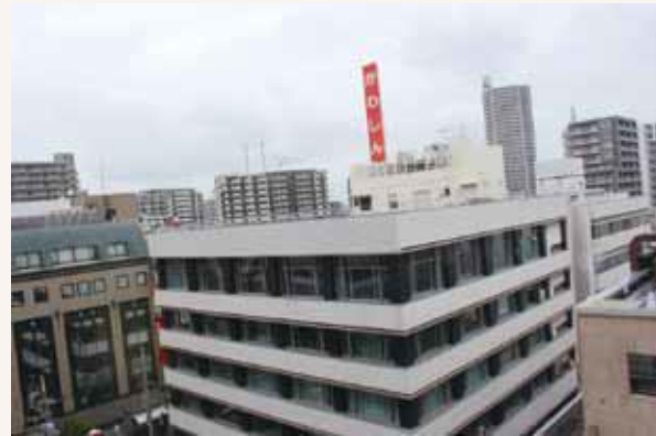
▲解体前の本店。間もなく工事作業が始まります（H26.6.5）
