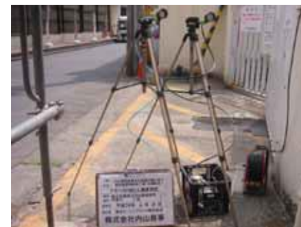
規制物質を含む建材の除去工事では空気中の濃度を監視。測定値を表示しました（写真・内山商事）
