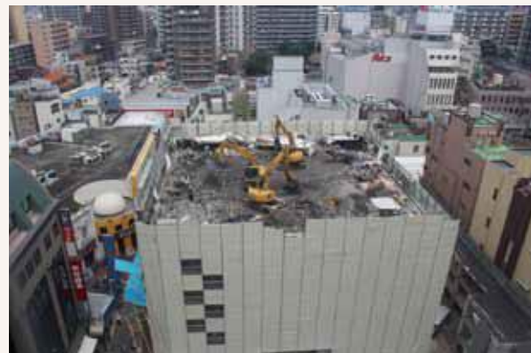
▲屋上から5階にかけて解体が進みました（H26.7.14）
