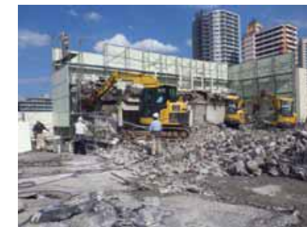
大型クレーンが入れず、安全確保のために「階上解体」を採用しました（写真・内山商事）
