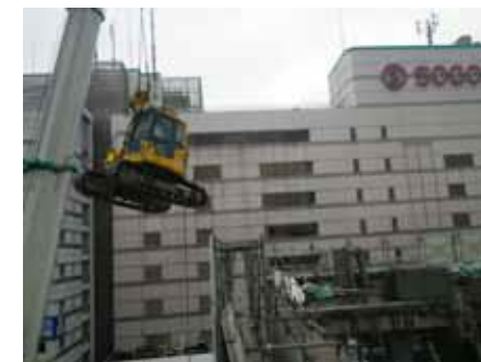
破砕重機をクレーンで屋上へ。アームなどを別々にして吊り上げました（写真・内山商事）
