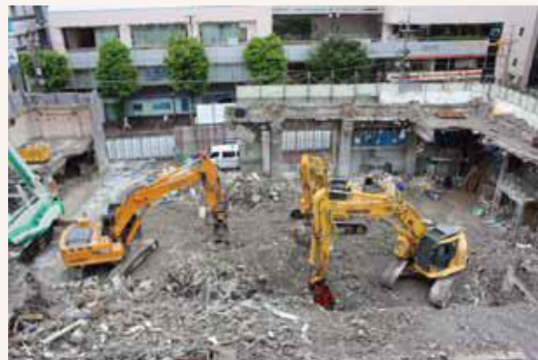
▲壁だけを残して地上まで解体が進みました（H26.8.27）
