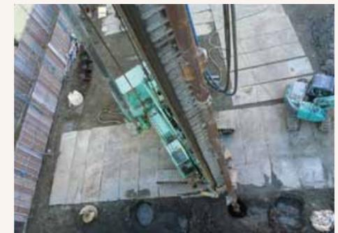
▲新築工事開始。基礎工事の杭打ち (27.2.10)
