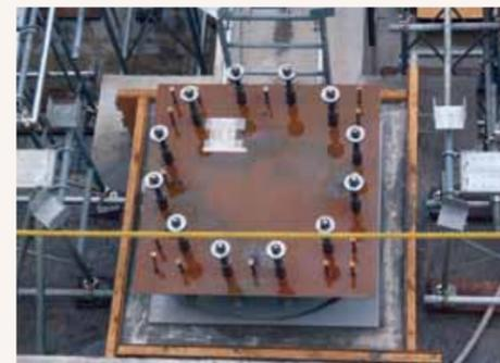
▲基礎の杭の上部に設置された免震装置 (27.9.11)
