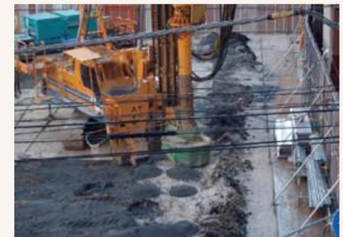
▲液状化対策と地盤改良。地下深くまで砂を注入する (26.10.29)
