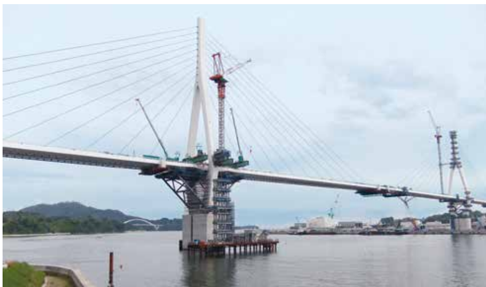
建設中の三陸縦貫自動車道・気仙沼湾横断橋（仮称）／斜張橋（680m）としては東北最大
