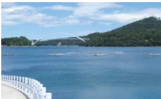
気仙沼大島と本土をつなぐ気仙沼大島大橋
