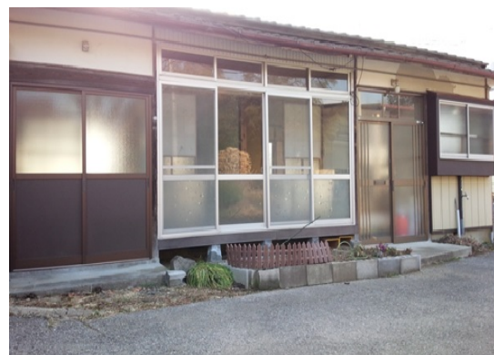
【改装中のつなぎハウス】
