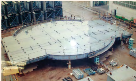
戎橋製造時の様子
