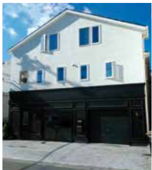
モノトンの外観がシックな新本社
