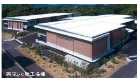
完成した新工場棟
