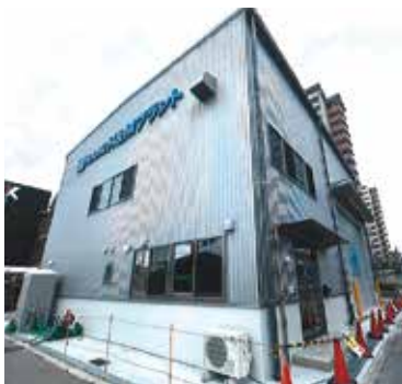
完成した新倉庫
