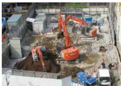
旧本店ビル解体工事の様子
