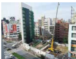
旧本店ビル解体工事の様子 (令和3年9月)
