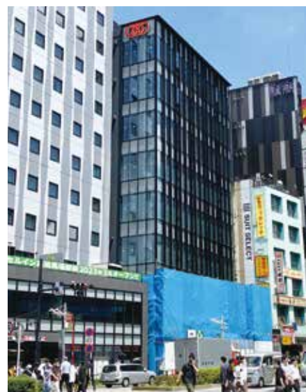
建設工事の様子(令和5年6月)
