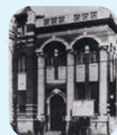
同栄信用金庫 本店営業部
